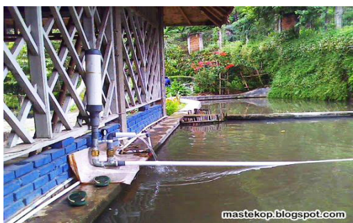
Gambar 1. Pompa hidram (Hidraulic Ram) sederhana
