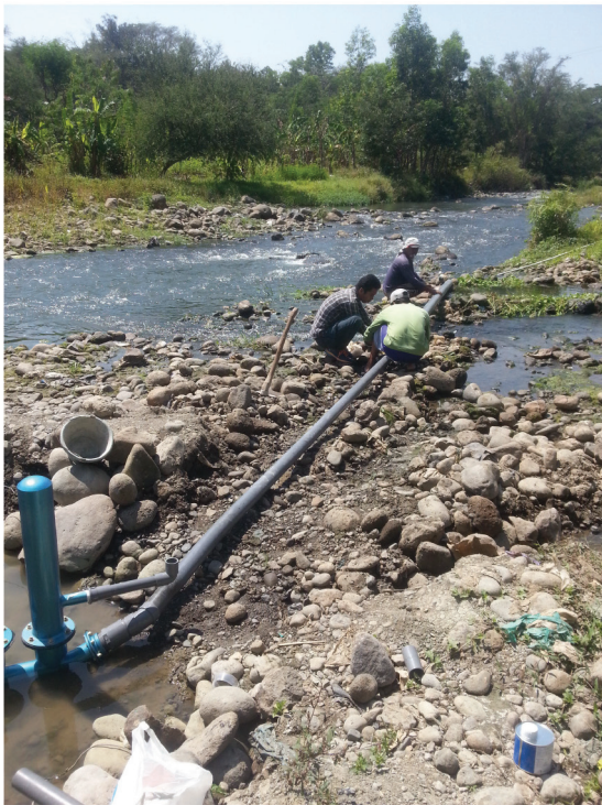
Gambar 8. Mencari Terjunan Air untuk Head Input
