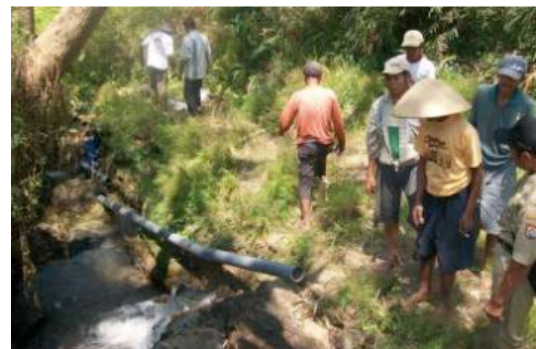
Gambar 10. Instalasi Pipa Pekat Dari Bendungan Ke Hidram, Mitra PKM Aktif Membantu
