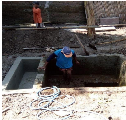
Gambar 4. Tempat pembuangan limbah biogas
