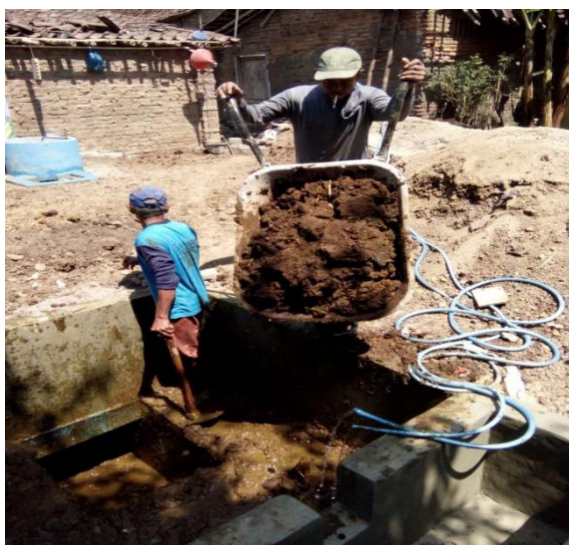
Gambar 2. Pembuatan degester dengan memasukkan kotoran sapi
