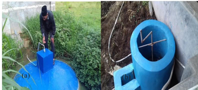
**Gambar 3 a).** Mixer pengaduk lumpur, dan b) Saluran biogas dari digester
