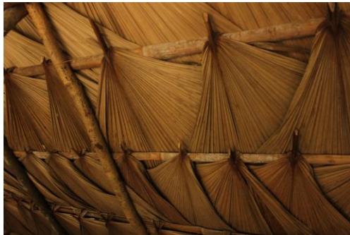
Gambar 4. Susunan daun woka sebagai atap Sumber : Dokumentasi Penulis (2018)
