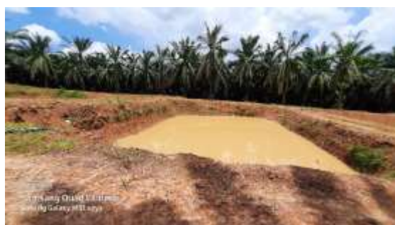
Foto 1. Sediment Pond kompartemen 1. Lokasi area berada pada area kebun kelapa sawit.
