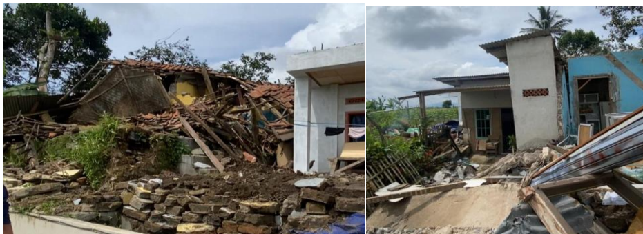
Gambar 1.2 Kondisi rumah warga Mangunkerta yang mengalami kerusakan
