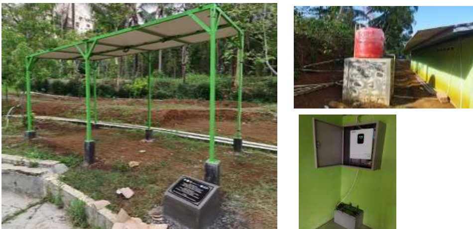
Gambar 2. sistem irigasi sprinkler bertenaga surya hybrid offgrid 2,2 KW
