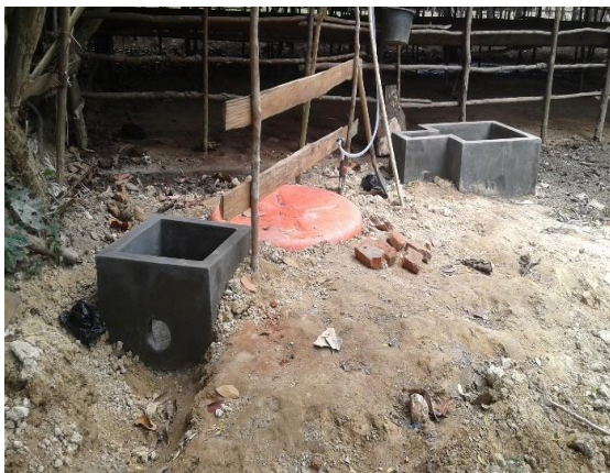
Gambar 3. Pemasangan Biogas berdekatan dengan Kandang
